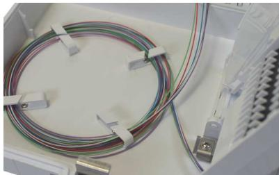
**Suba los micromódulos hacia la parte trasera de la bandeja extraíble, donde podrá almacenar la fibra sobrante tras la fusión.**
